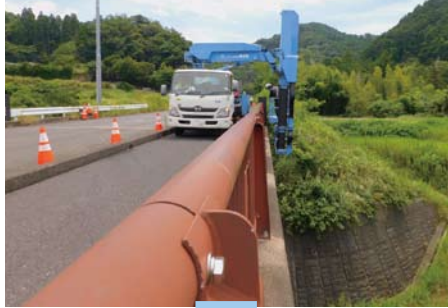
橋梁点検（橋梁点検車利用）
